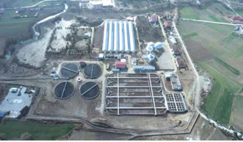
Kütahya Atıksu Arıtma Tesisi - 97.705 m 3 /gün kapasiteli
