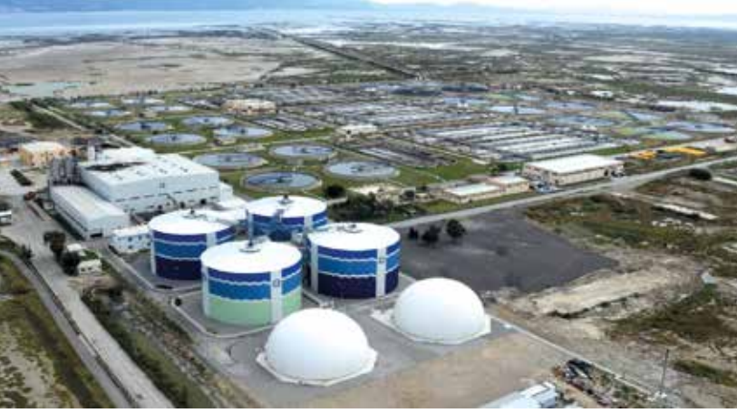
Çiğli Atıksu Arıtma Tesisinde Çamur Çürütme ve Çamur Kurutma Tesisi
